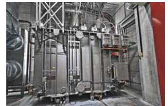
Ein 50-MVA-Leistungstransformator mit kompakten Connex-Anschlüssen in einer unterirdischen Transformatorzelle des neuen Umspannwerks Oerlikon.
