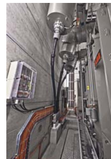
Berührungssicher unter Hochspannung: Drei Kabelanschlüsse am 50-MVA-Transformator ausgeführt mit gekapseltem HV-Connex-System für 170 kV.
