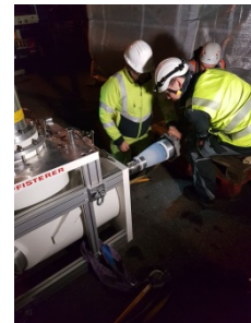
Premiere: Auf der Plattform DolWin gamma wurden hochflexible 155-kV-Kabel mit steckbaren Connex-Anschlussgarnituren installiert. Damit ist die Onshore-Installation abgeschlossen. Im nächsten Schritt erfolgt die Offshore-Montage durch Pfisterer. Mitte Juni verließ die Plattform das Dock in Warnemünde.
