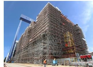
Mit den Onshore-Arbeiten zur Verkabelung der Plattform DolWin3 hat Pfisterer bereits begonnen. Danach folgt die Offshore-HV-Verkabelung. Erstmals werden dann zwei Plattformen über eine Brücke mit einer hochflexiblen 155-kV-Leitung verbunden – mit einer Länge von über 200 m zugleich die längste Verbindung zwischen zwei Plattformen weltweit.
