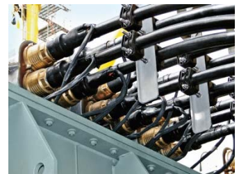
Das trocken steckbare Anschluss-System HV-Connex ist durch seine zeitsparende, einfache Montage besonders geeignet für Offshore-Projekte und Hochspannungsnetze.
